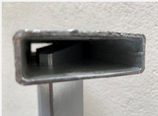
Foto 3 - detail niet zichtbare verzinkgaten in geval van een lamellenhekwerk
