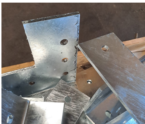
MC staal dat onverzinkte plekken vertoont vanwege oxidevorming veroorzaakt door thermisch snijden
