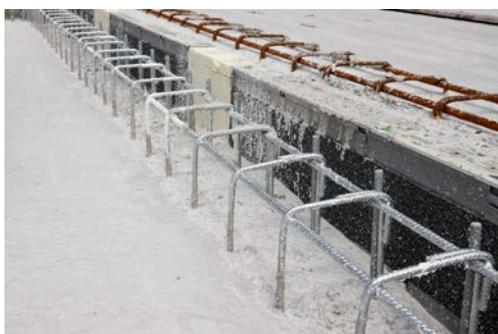
**(Photo ci-dessus)** Armature traditionnelle dans du béton constructif à côté d'une armature galvanisée dans du béton apparent, séparée par une interruption thermique.
