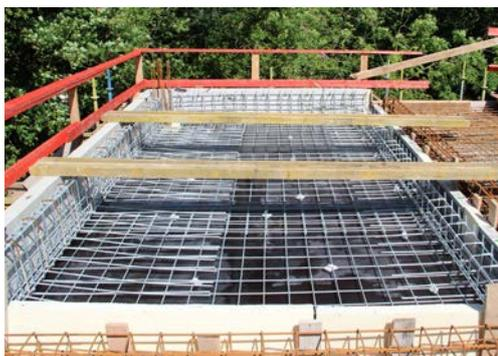
**(Photo ci-dessus)** La terrasse est prête pour le coulage du béton.
