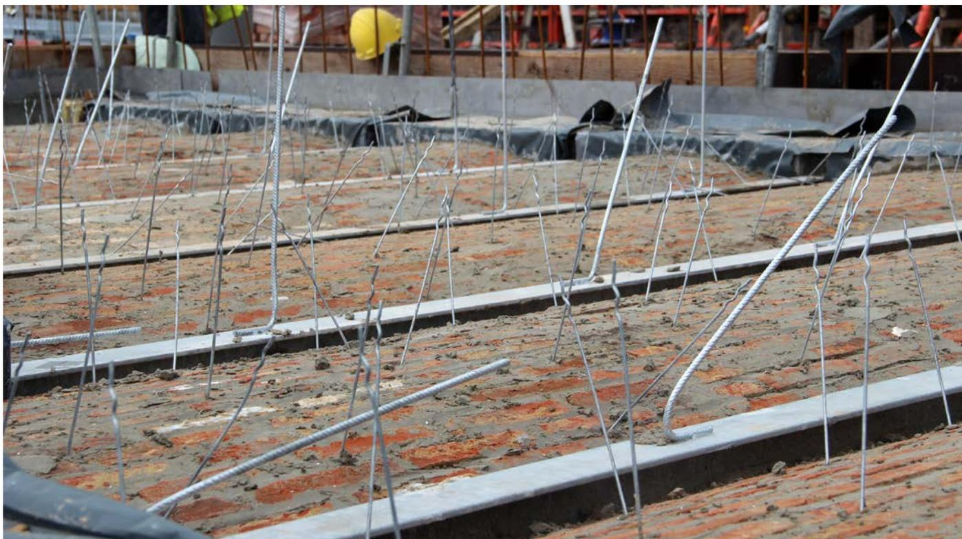
*(Photo ci-dessus)* Profilés galvanisés avec armature galvanisée soudée pour le ferrailage dans l'armature de la chape de la cave.
