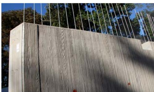
**(Photo ci-dessus)** L'armature d'attente a été galvanisée pour éviter les traces de rouille.
