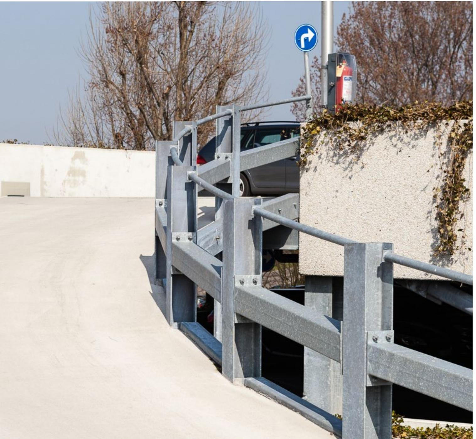
Le bâtiment a quatre niveaux avec un parking à vélos au niveau 0. Les zones de parking non couvertes ont été munies d'un revêtement de sol antidérapant. Le début de chaque rampe d'accès a été équipé d'un caniveau à fente pour éviter les excès
