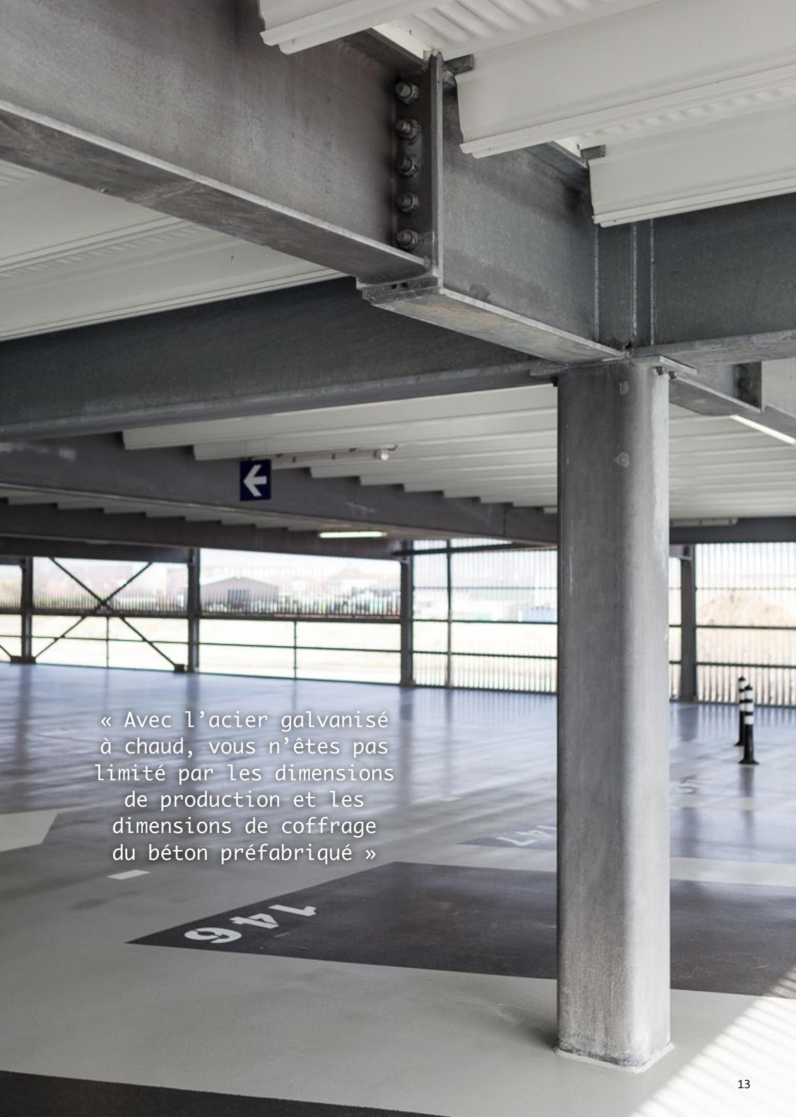
« Avec l'acier galvanisé à chaud, vous n'êtes pas limité par les dimensions de production et les dimensions de coffrage du béton préfabriqué »
