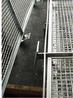
issues du laminage et/ou de contraintes de soudage, s'équilibrent mutuellement et ne provoquent donc pas de déformations. La chaleur pendant la galvanisation peut perturber cette situation d'équilibre et entraîner des déformations dans la structure. L'ampleur de la déformation éventuelle dépend entre autres de :
