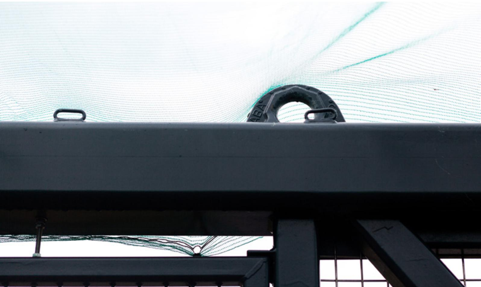
Frank de Groof : « Quatre gros crochets fixés sur le haut permettent de soulever le pont à l'aide d'une grue, les crochets plus petits sur les côtés sont prévus pour accueillir des toiles ou une protection antichute supplémentaire. L'organisateur de l'événement peut 'emballer' le pont au gré de ses envies et accrocher sa publicité à ces crochets.
