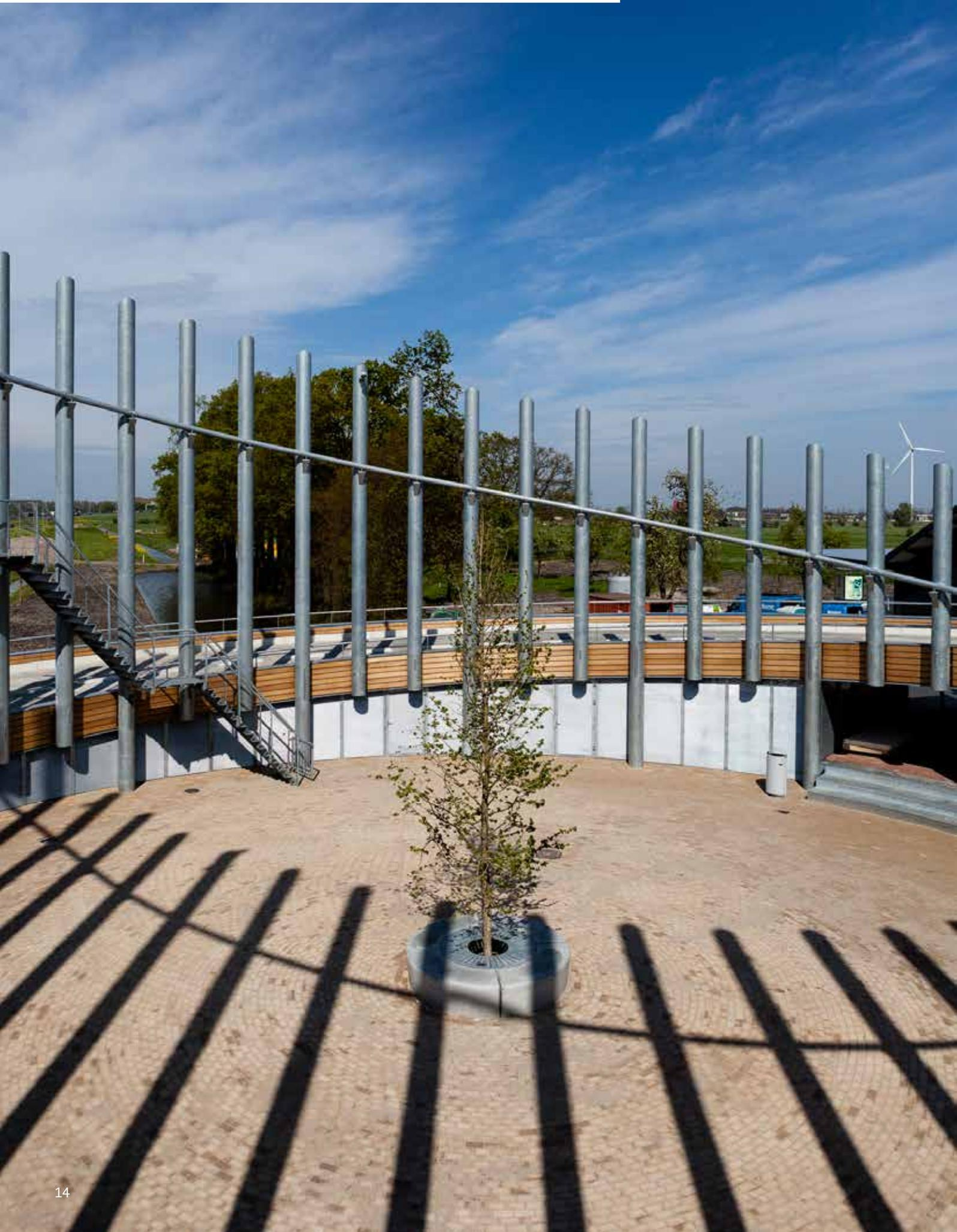
**Leo van Dijk:** Ce qui retient le plus le regard, ce sont les colonnes en acier de hauteur dégressive au centre de la rampe. Elles conduisent littéralement les visiteurs au parc de stationnement et elles assurent la visibilité lointaine du transferium. On a utilisé au total environ 250 tonnes d'acier, dont la plus grande partie a été galvanisée à chaud.
