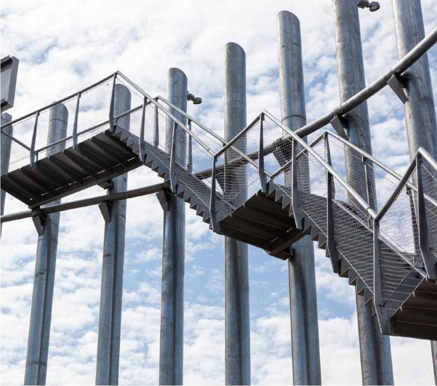
seul tenant, assure une résistance et une rigidité suffisantes. Les marches d'escalier sont soudées sur un caisson de torsion qui est fixé aux colonnes en acier du transferium. Avec cette technique de construction, il n'y a pas besoin de pieux de fondation supplémentaires.
