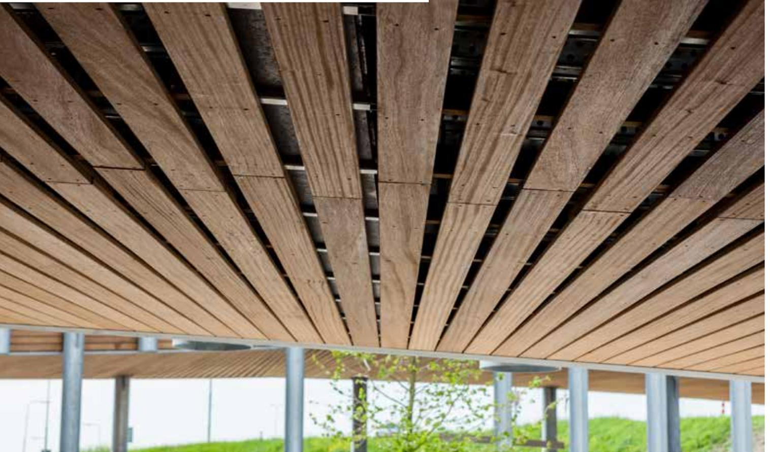
Le bois est un deuxième matériau de base du transferium. Une essence judicieusement choisie s'adapte bien aux détails en acier galvanisé. Ces matériaux s'équilibrent paisiblement et intègrent des fonctions et des éléments différents au sein d'un tout cohérent. Pour les lamelles, on a bien testé une dizaine d'essences
