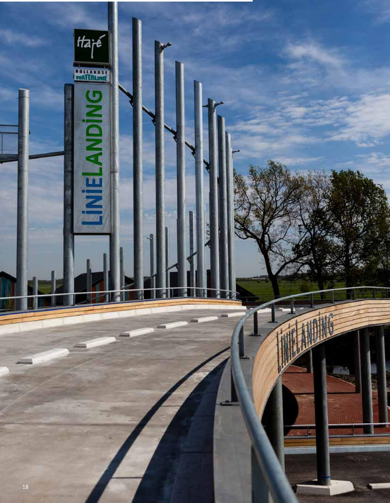
Le tablier de la rampe est muni d'un chauffage électrique. Lorsque la température descend au-dessous d'une valeur donnée, le chauffage se met en marche automatiquement. Ainsi, le tablier ne gèle jamais pour garantir la sécurité des voitures qui montent et descendent.
