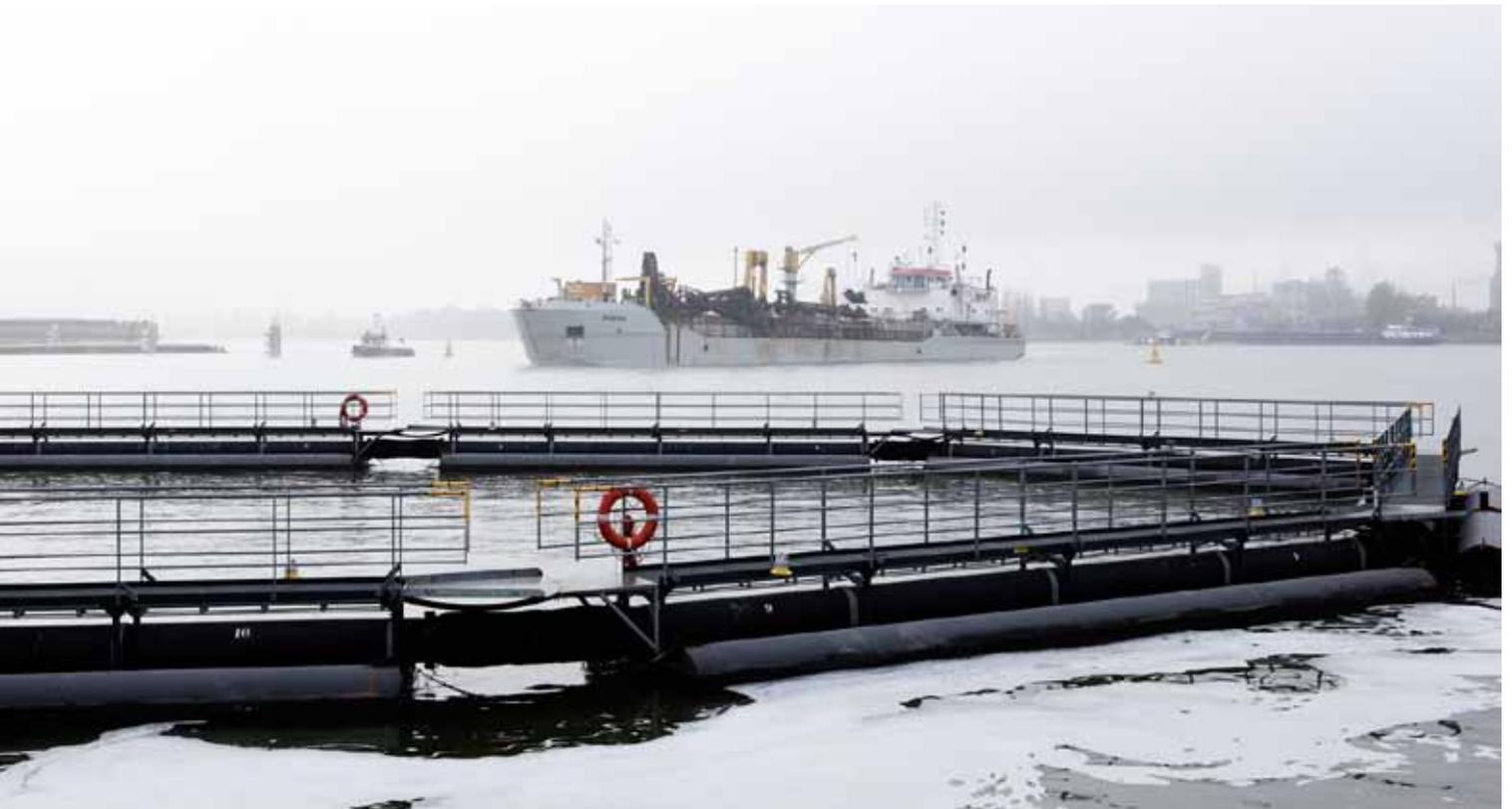
Des dragues de l'Entreprise portuaire d'Anvers transportent les boues de dragage d'entretien vers une cellule sous-marine de 300 000 m<sup>3</sup>. Une drague suceuse à roue coupante, qui a reçu le nom approprié d'Amoris, réaspire ensuite les boues et les achemine vers une installation de séparation de sable sur le quai voisin par l'intermédiaire d'une conduite flottante.
