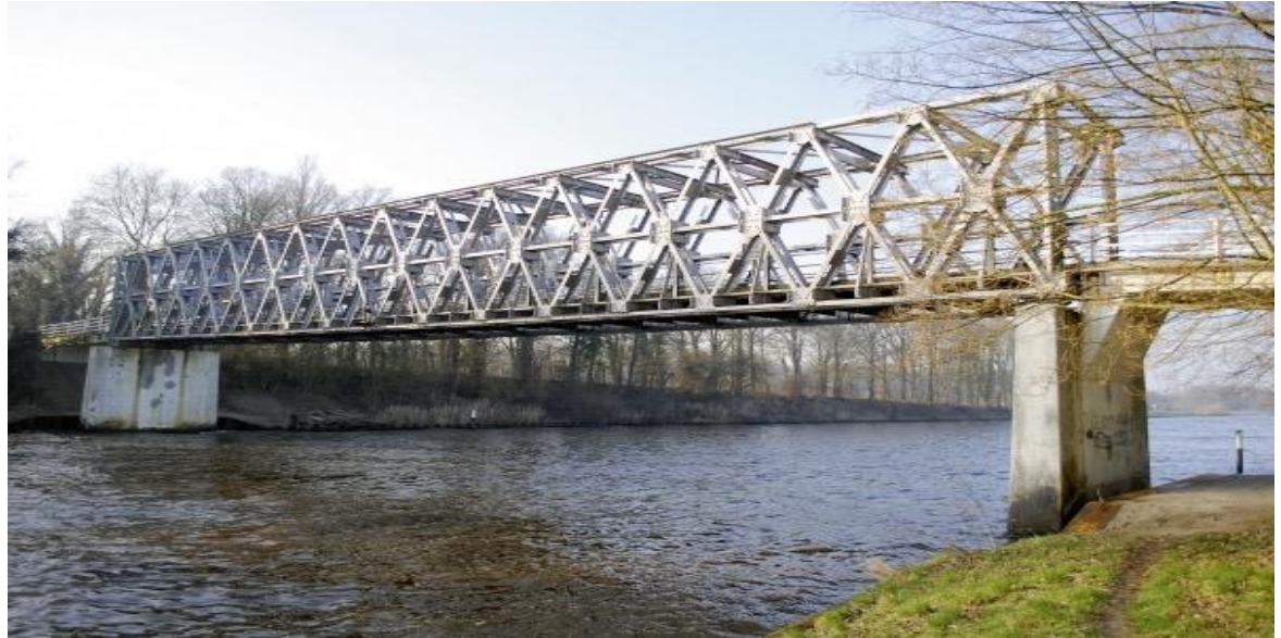
Ehzerbrug in Almen (1945)
