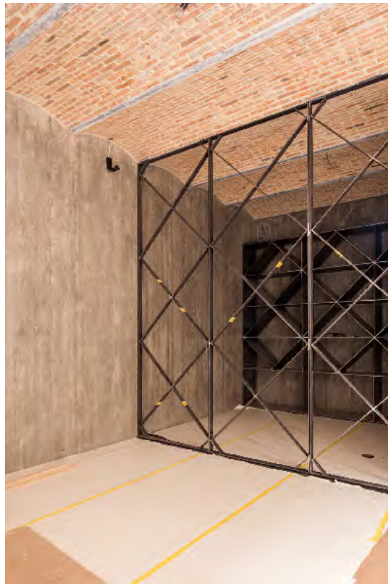
(Beeld hierboven) Zicht op de rest van de kelder.
