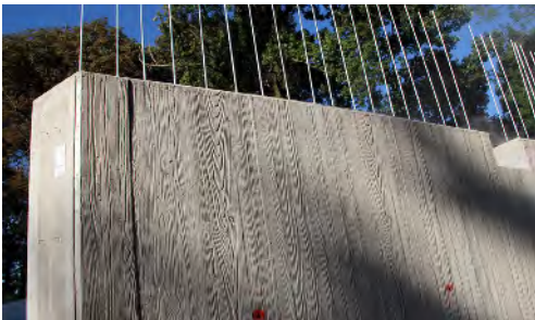
(Hierboven) De wachtwapening werd gegalvaniseerd om roeststrepen te vermijden.
