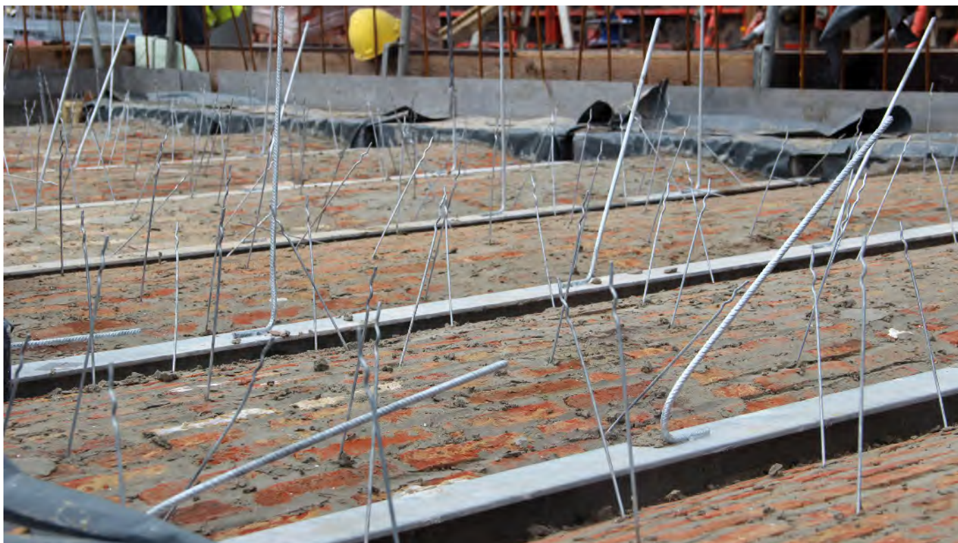
(Hierboven) Gegalvaniseerde profielen met aangelaste gegalvaniseerde wapening om in te vlechten in de wapening van de afdekking van de kelder.
