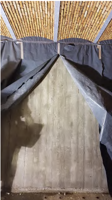
(Beeld hierboven) In deze betonnen muur met houtnerfstructuur bevindt zich de gegalvaniseerde wapening van pagina 10. Alles werd ter plaatse gestort.
