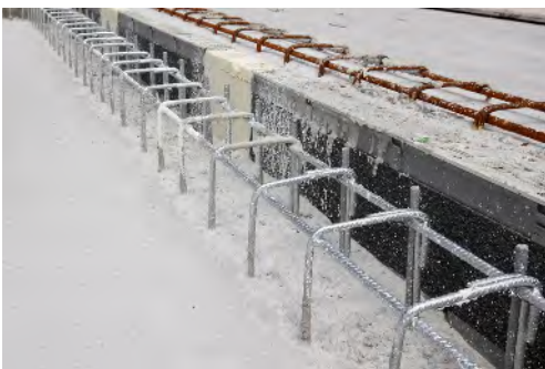
(Beeld hierboven) Traditionele wapening in constructieve beton naast gegalvaniseerde wapening in zichtbeton, gescheiden door een thermische onderbreking..
