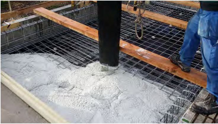
(Beelden hierboven, links) Storten wit zichtbeton voor de afdekking van de terrassen.
