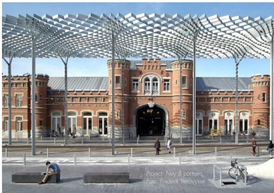
Bij het gebruik van diverse, identieke pilaren kan esthetisch verzinken zorgen dat elk element er identiek uitziet
