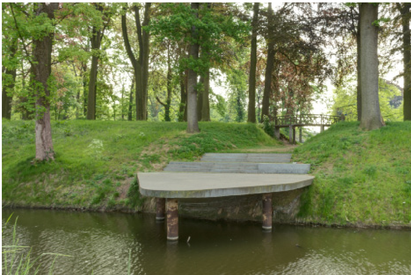
verbinding door de talud naar de zitvlonder - fotografie Abscis Architecten
