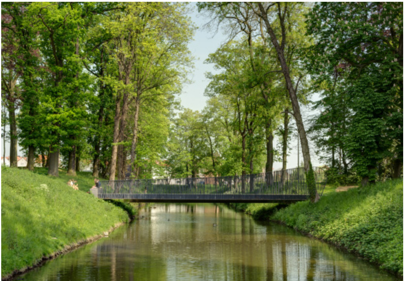
voetgangersbrug - fotografie Abscis Architecten
