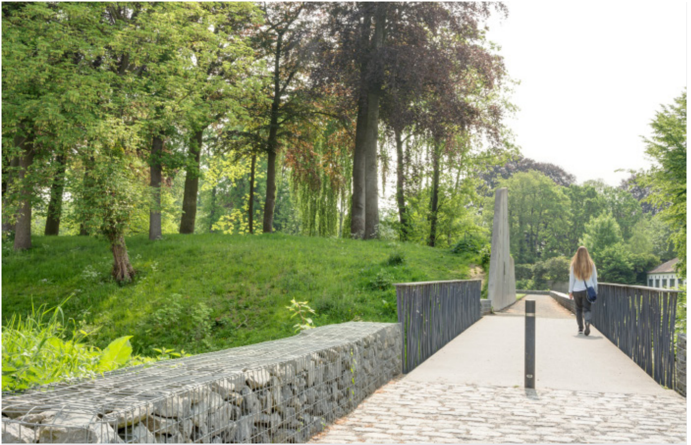
nieuwe parkverbinding, wandel- en fietsbrug over Ravelijngracht - fotografie Abscis Architecten
