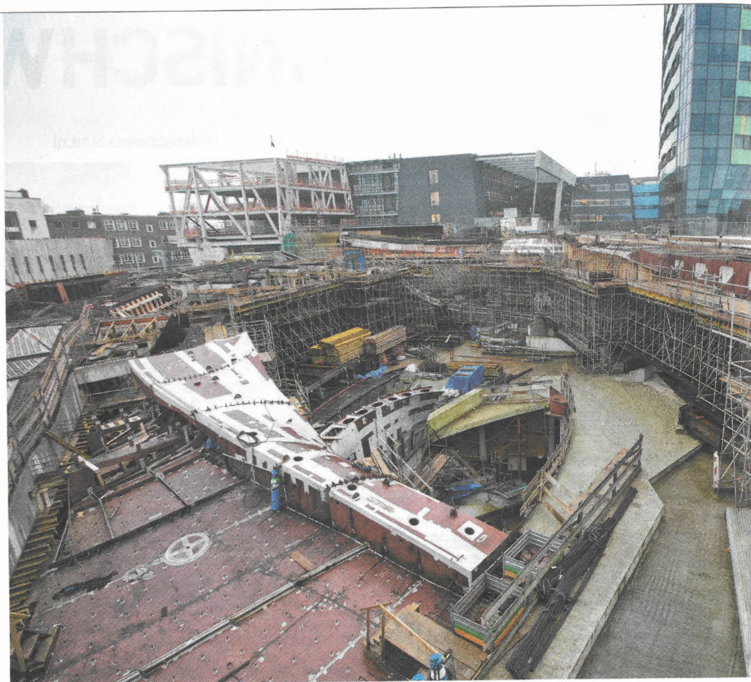
'De stationshal is geen gebouw, maar een kunstwerk', stelt Karin van Helmond, ProRail-projectmanager. 'Het ontwerp kent geen rechte lijnen, alles is gebogen.'
