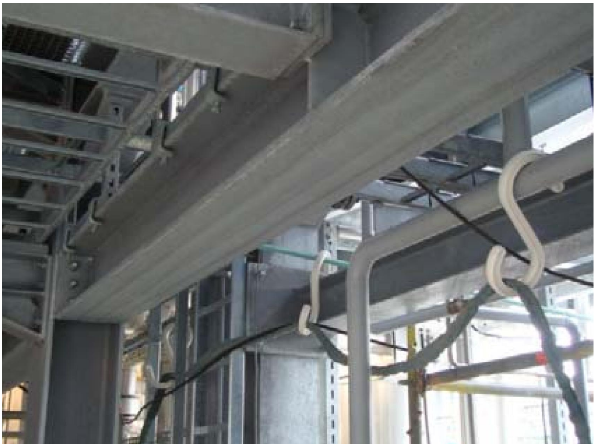
Plaatsen van kabelladders en tijdelijke kabelhaken aan de galva structuren
