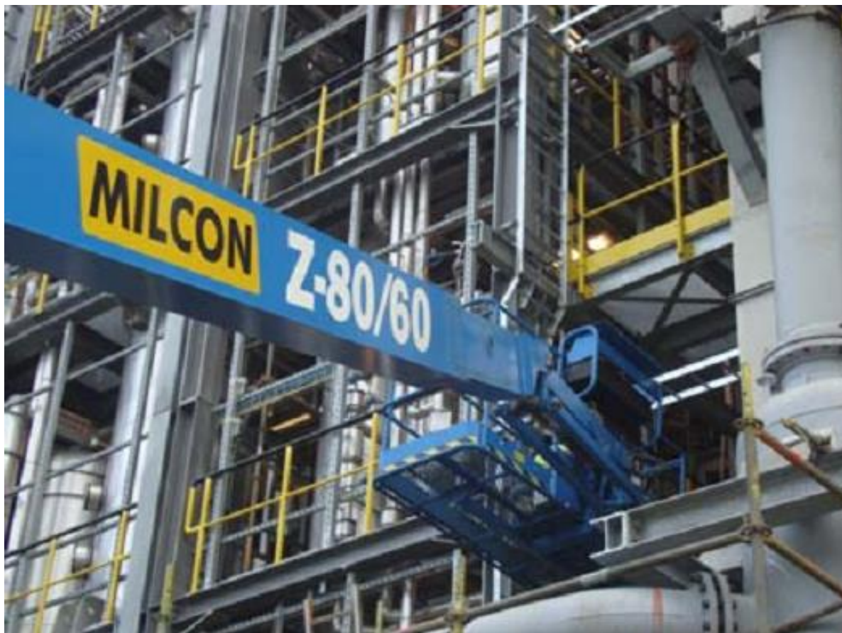
Plaatsen van kabelladder op de galva structuren
