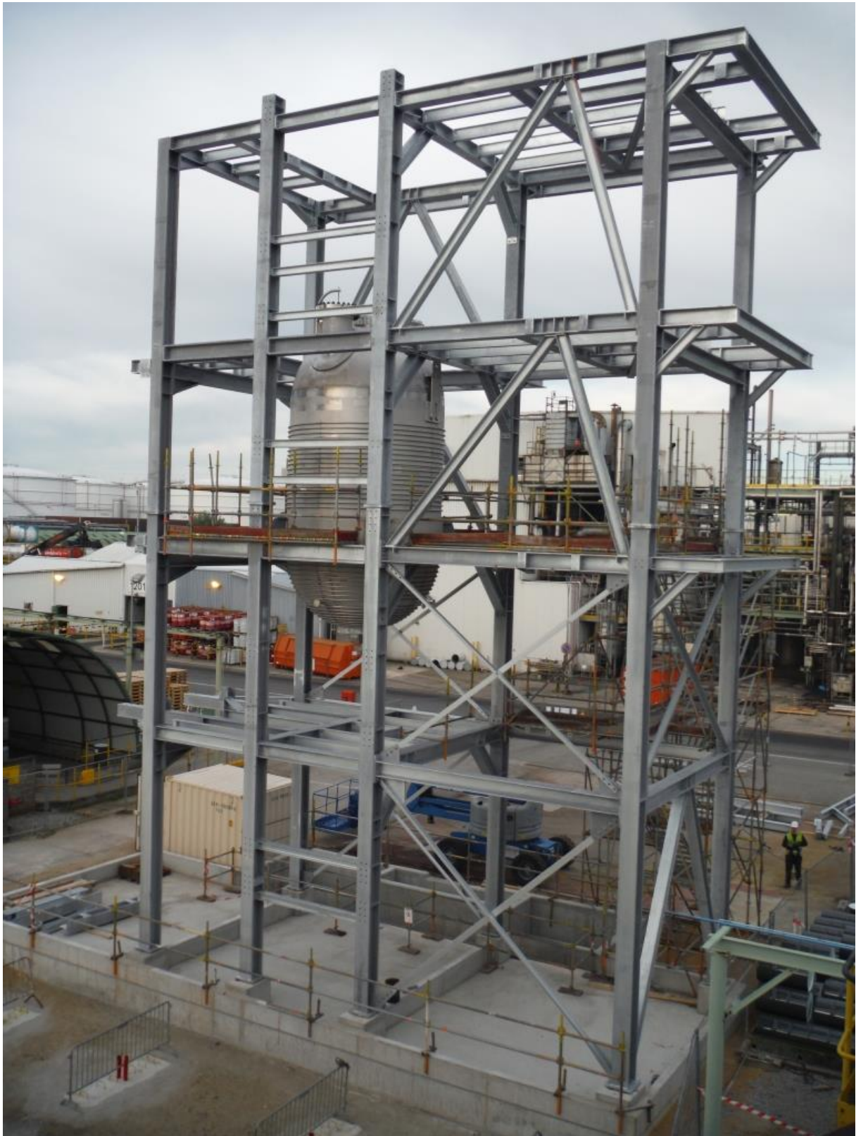
Reactorstructuur: kolommen en hoofdliggers worden voorzien van fireproofing bovenop de galvanisatie
