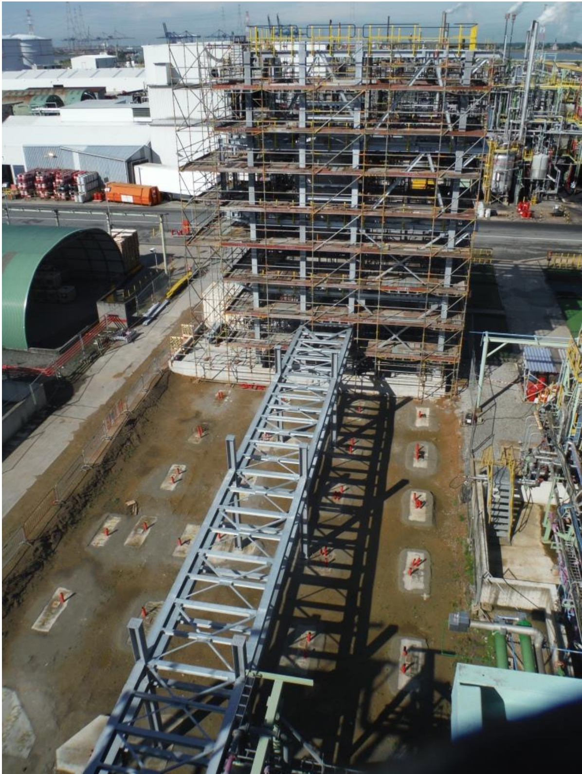
Opbouw van 1 e niveau piperack aansluitend op reactorstructuur
