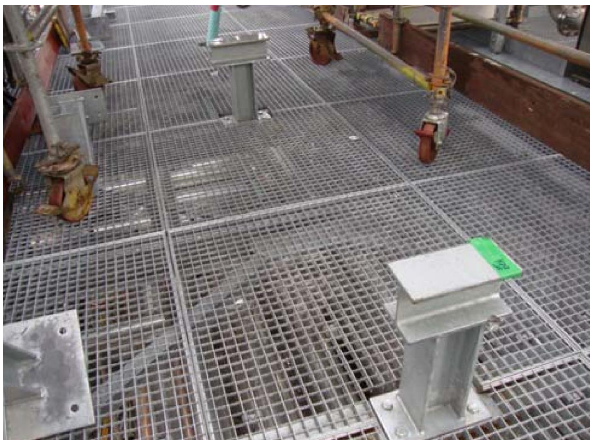
Vloeren bestaan 100% uit gegalvaniseerde roosters
