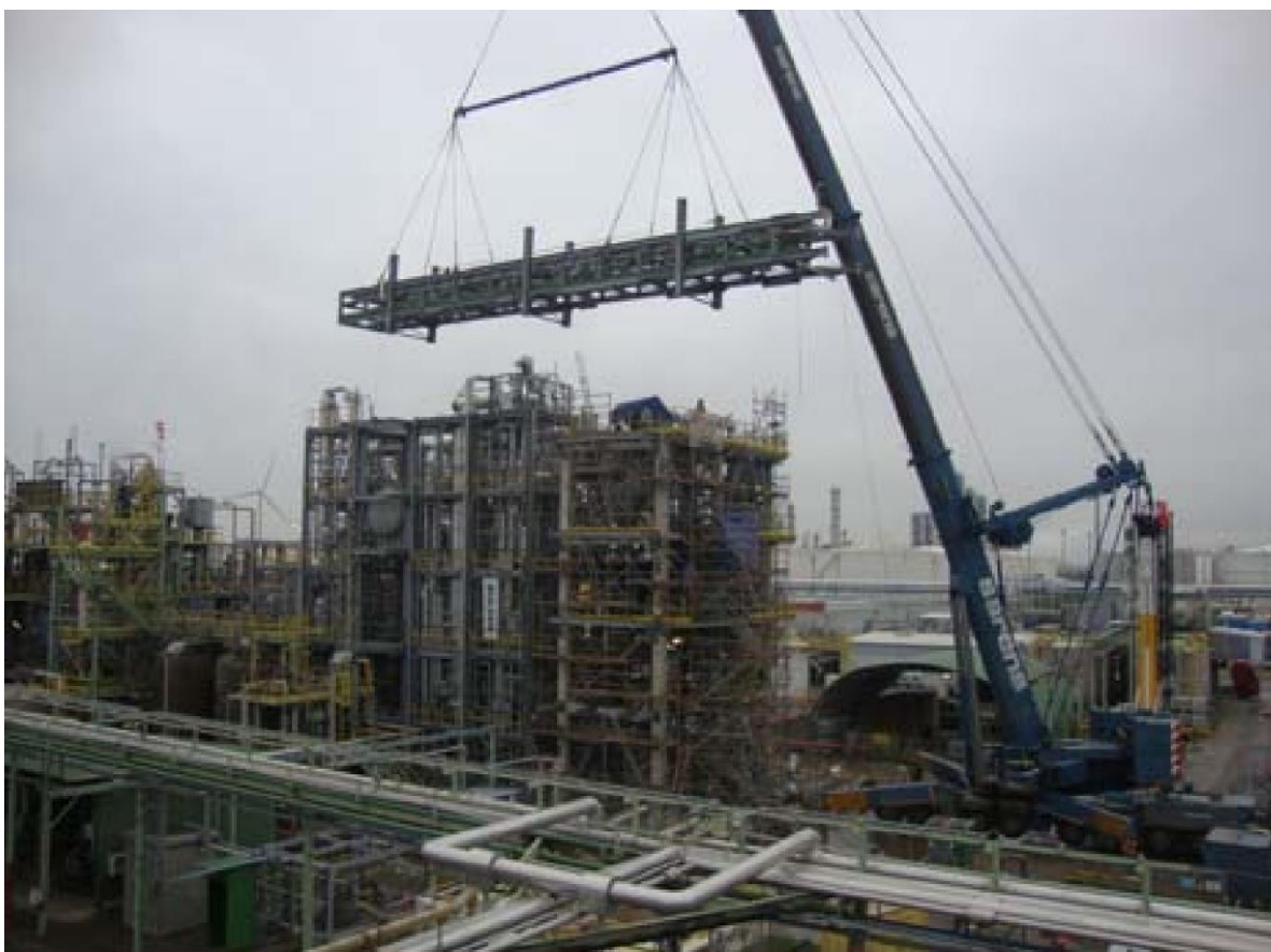
Hijzen van 1 van de 4 voorgemonteerde modules van de piperack tussen de reeds geplaatste productiemodules en reactorstructuur met mastodont van kraan
