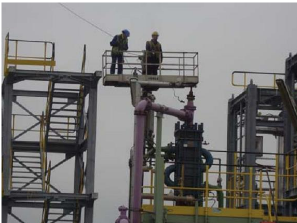
Aansluiten van piping op equipment op de galva structuren
