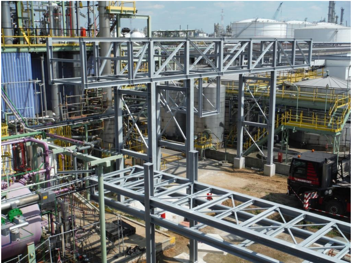
Opbouw piperack aansluitend op reactorstructuur
