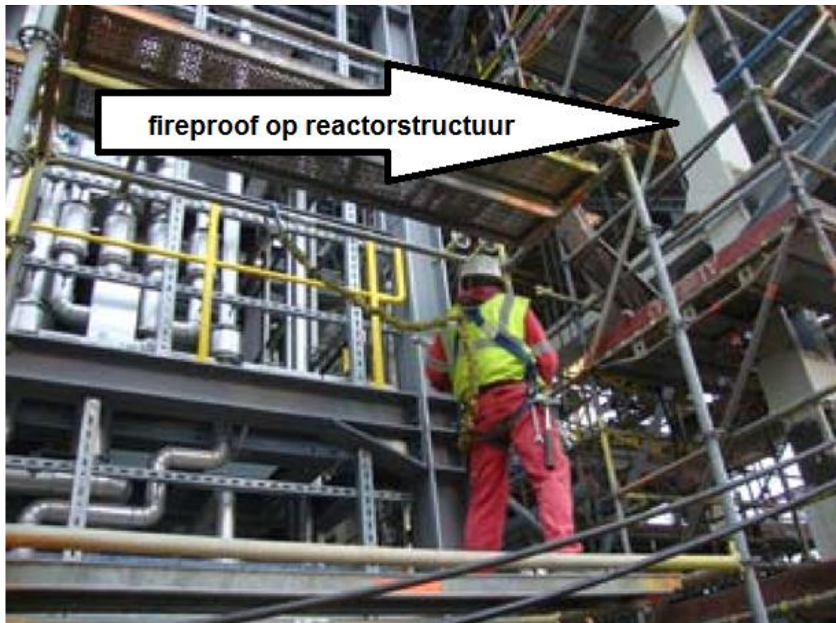
Aanbrengen van fireproofing op gegalvaniseerde structuren reactor
