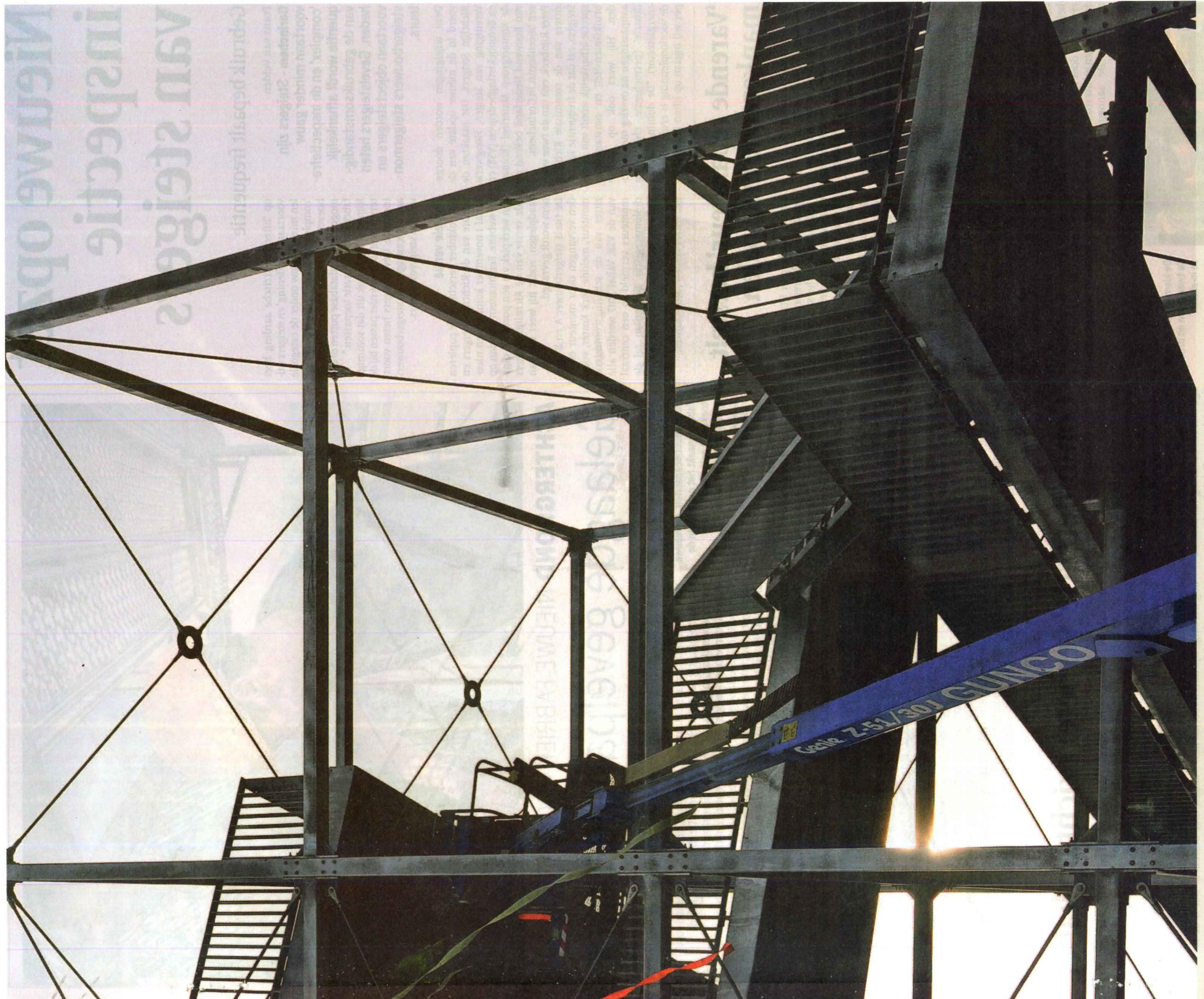
van compositiet en zijn door middel van trappen met elkaar verbonden. Aan de onderzijde van de balkons is led-verlichting aangebracht, die in het donker in combinatie met strekmateriaal beplating zorgt voor fraaie lichteffecten. Het stalen frame geeft de toren door middel van kruisellings geplaatste trekstangen zijn benodigde stijfheid.
