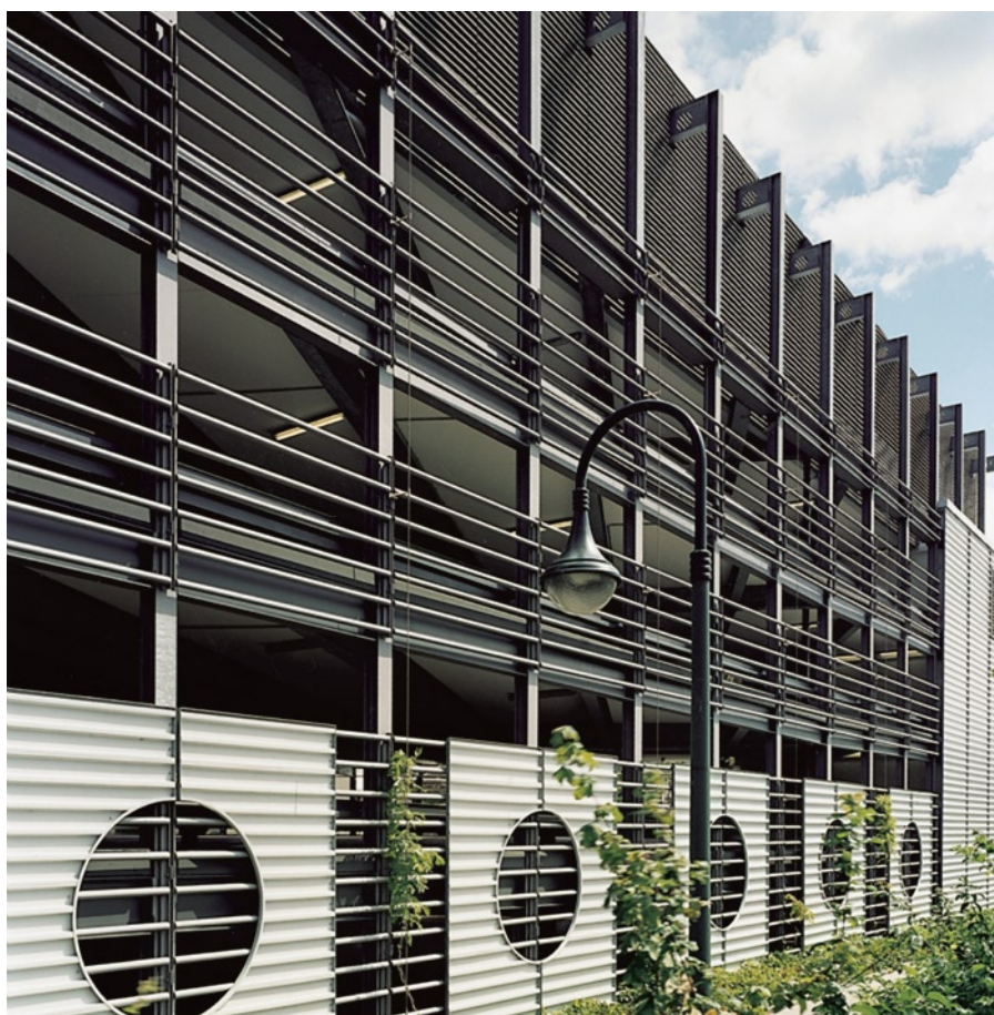
Fig 4. Réduction du potentiel de réchauffement climatique : protection par galvanisation à chaud pour un parking en structure acier (500t d'acier structurel)
