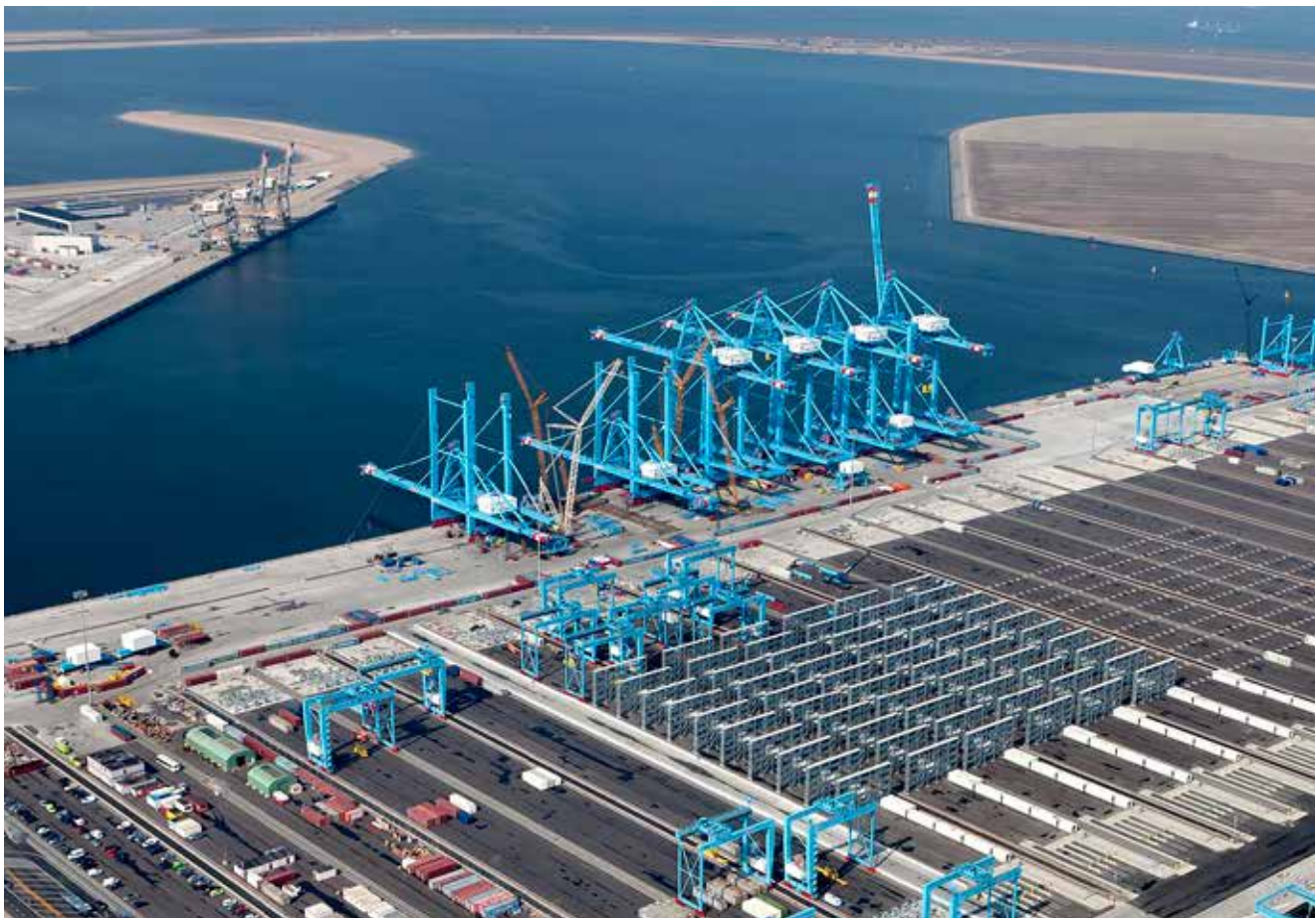
© R. van Leeuwen & Voortman Steel Construction
