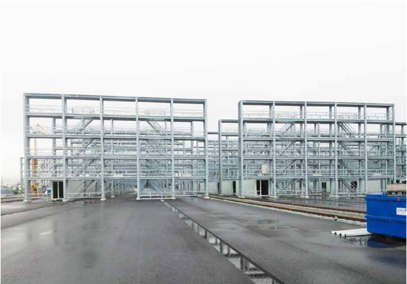
© R. van Leeuwen & Voortman Steel Construction
