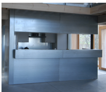
Een grote functionele kern in het midden van de ruimte met de keuken, toiletten, badkamer en wasruimte bekleed met staal
