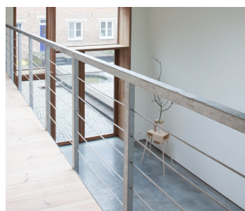
Het hekwerk is thermische verzinkt staal met stalen draden
