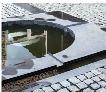
Stalen waterloop detail naar betonnen waterpartijtijn de binnenplaats
