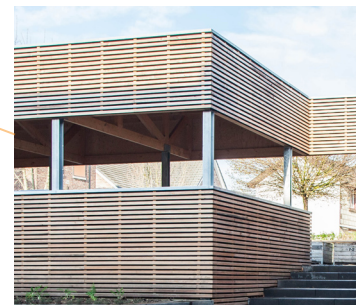
Thermische verzinkte stalen kolommen die het dak van de carport dragen
