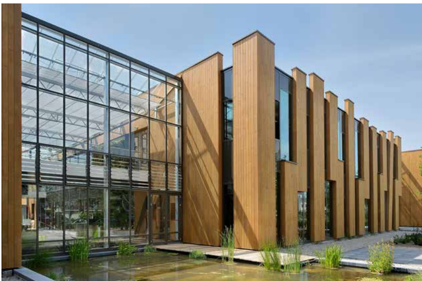
© Chiel de Nooyer, Architectuurfotografie SP Architecten
