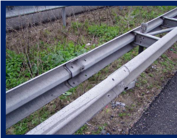
foto 14: losmaken planken per 12 meter
