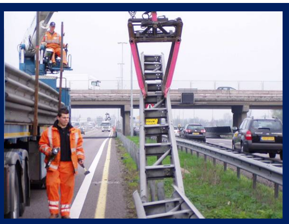
foto 15: opladen 12 meter delen
